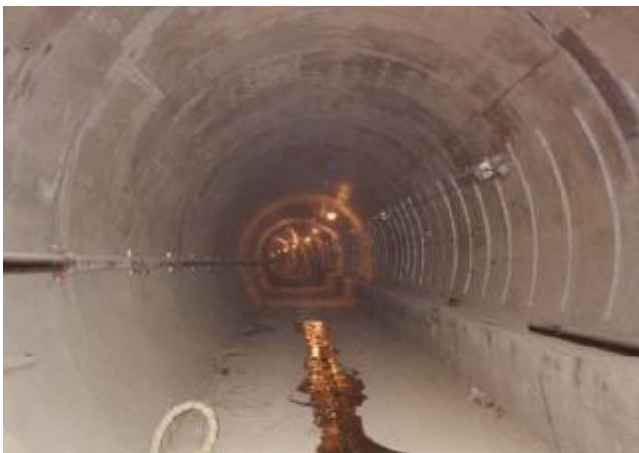
ภาพผนังอุโมงค์แบบคอนกรีตหล่อในที่ (Washington DC)
