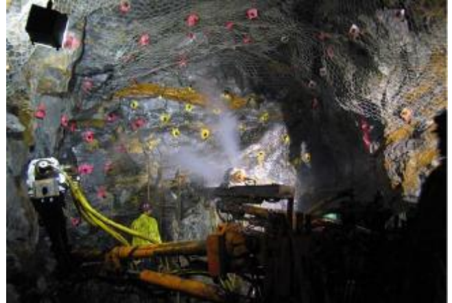
ภาพการเจาะรูหินเพื่อเตรียมการระเบิดหินภายในอุโมงค์
