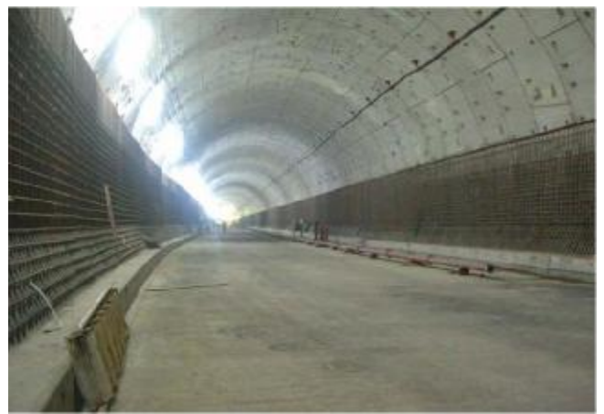
ภาพผนังอุโมงค์แบบคอนกรีตหล่อสำเร็จ (Malaysia)
