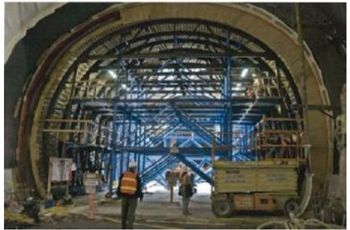
ภาพอุโมงค์ภายหลังจากติดตั้งค้ำยันอุโมงค์ขั้นสุดท้าย
